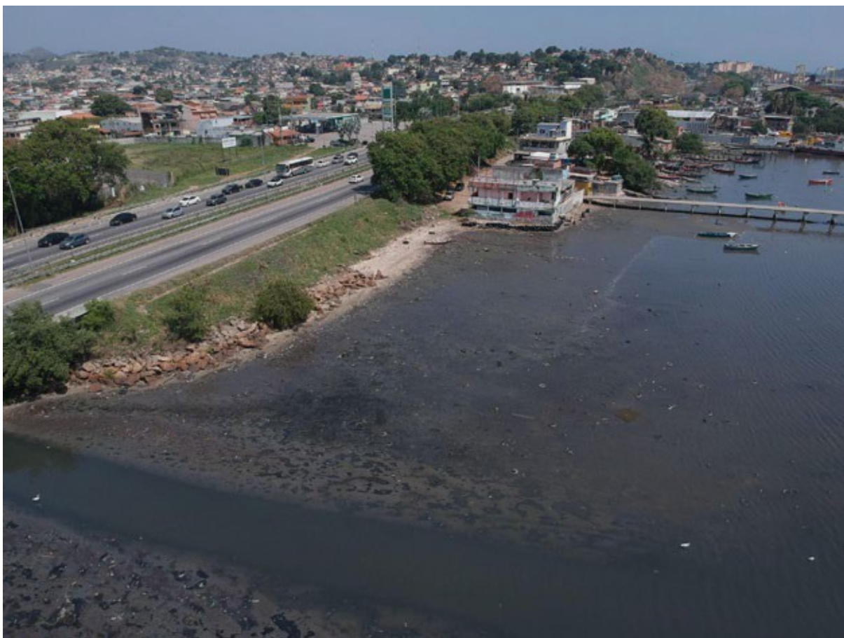
Figura 1 - Mostra o despejamento de esgoto próximo ao cais do Gradim, além de reforçar a proximidade da mesma com a BR 101, em São Gonçalo, imagem de drone, registrado no ano de 2020.
