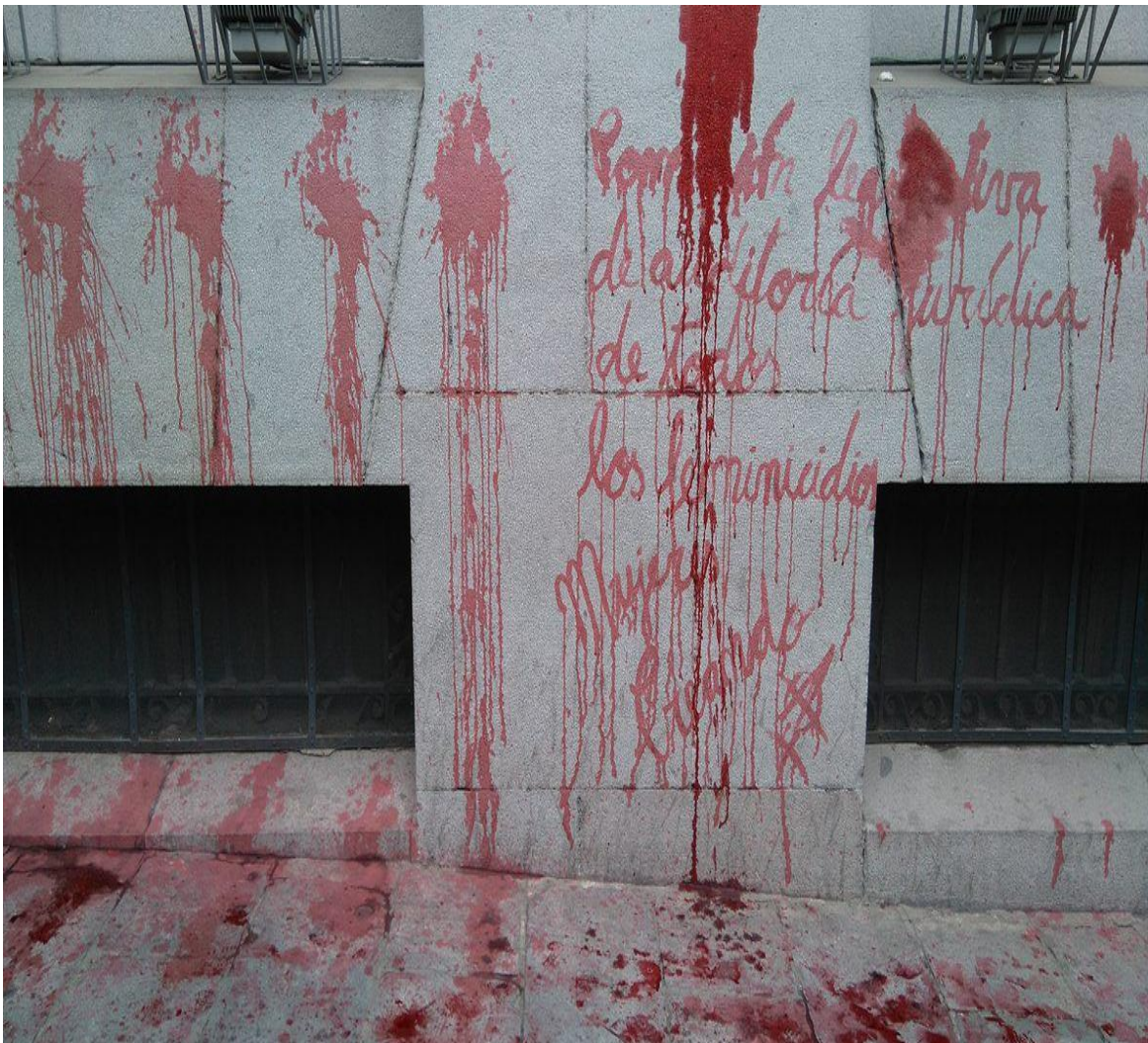
22 de novembro, lateral do prédio da vice-presidencia do estado plurinacional de Bolívia. La Paz, Rua Mercado. Foto por Ana Luiza Schuchter, 2016.
