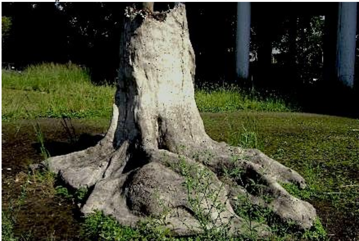
Figura 12 – Parte de concreto armado de Mutatis Mutandis - Fundão/2007
