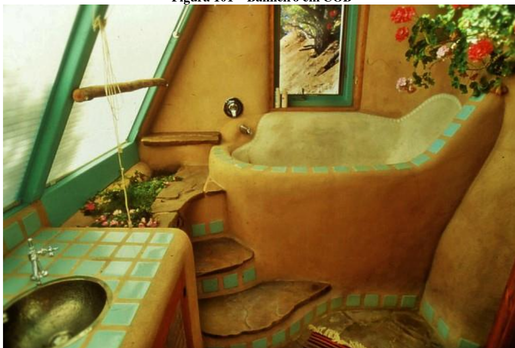
Figura 101 – Banheiro em COB
