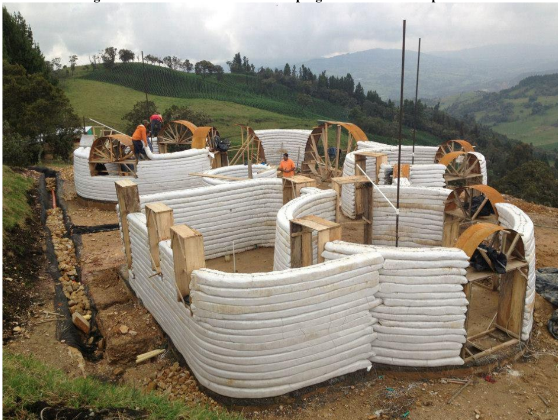
Figura 100 – Processo construtivo em progresso/Técnica do superadobe
