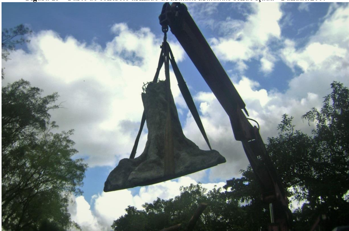
Figura 13 – Parte de concreto armado de Mutatis Mutandis sendo içada - Fundão/2007
